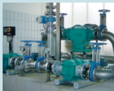
Multichopper per lacerazione e condizionamento con pompa rotativa a lobi per alimento centrifuga.
